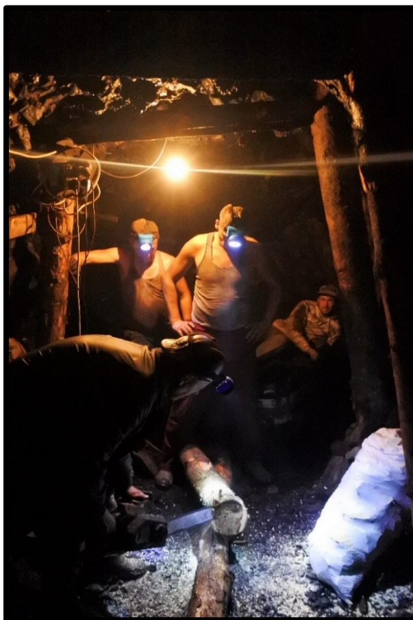
Fig. 13. Taglio dei tronchi di ciliegio per la costruzione delle impalcature del tunnel durante il primo giorno di lavoro presso la jama di RZ.
