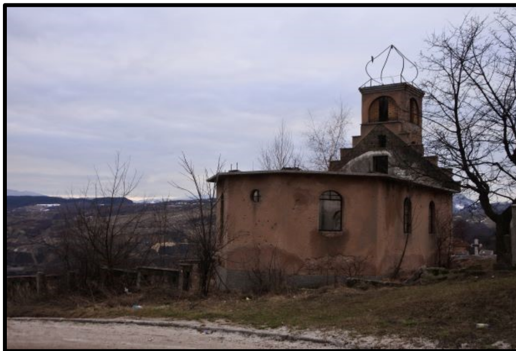
Fig. 15. La chiesa ortodossa di Gradišće vandalizzata e traforata dai proiettili. Sullo sfondo, la Brdo deturpata dagli scavi delle miniere a cielo aperto.
