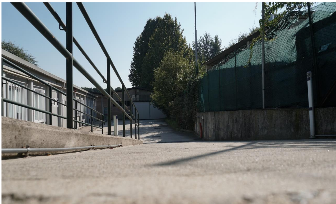
Figura 6: Vista al di là del cancello del dormitorio di strada delle Ghiacciaie, sulla sinistra la struttura a container in cui è ubicato il dormitorio.
