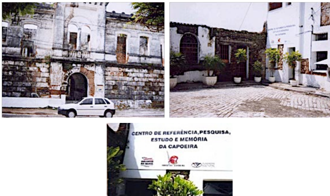
Figura 40: Imagens do forte de Santo Antônio antes da reforma.
