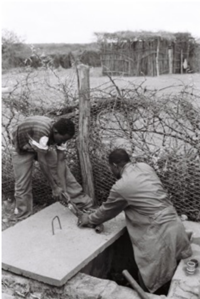
Reparations d'un point d'eau par le personnel de la ONG LVIA dans le village de Mubarak (2008)
