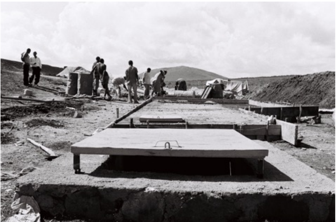
Construction d'un birked (2011)
