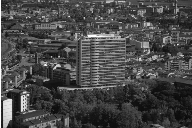
Fig. 2: veduta panoramica Grattacielo dei Mille, via dei Mille, Quartiere Roma. Fonte: Agenzia QR.
