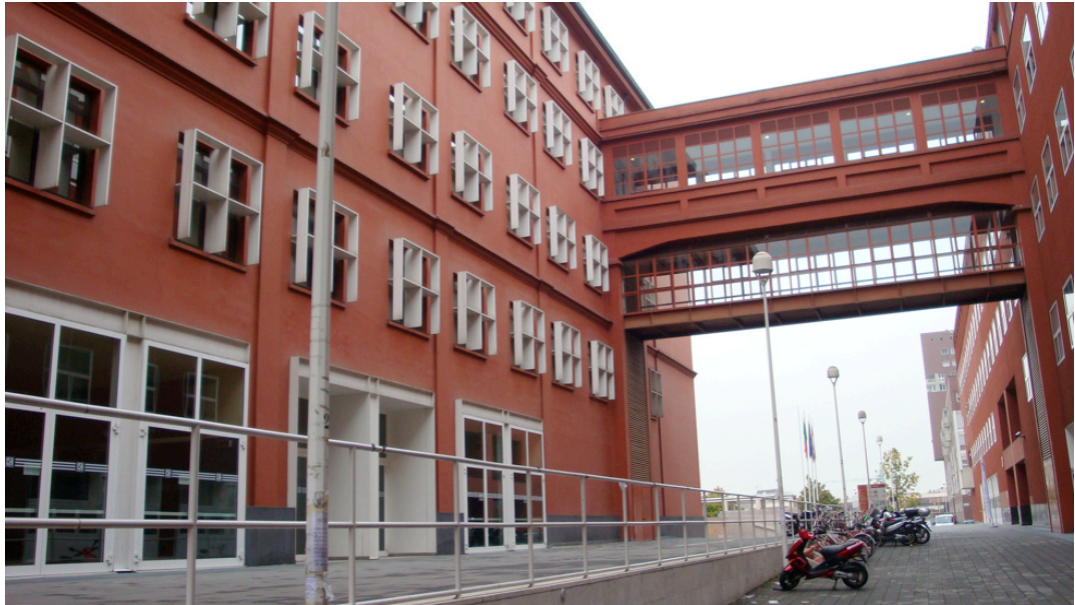
Figura 5 Il ponte che collega gli edifici U6 e U7 dell'Università degli Studi di Milano Bicocca
