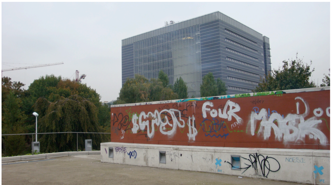
Figura 4 La Torre di Raffreddamento vista da Via Bicocca degli Arcimboldi (2009)
