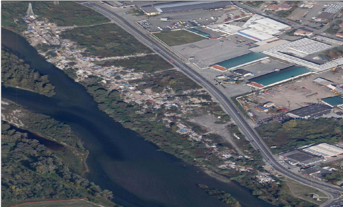
Figura 6 L'insediamento abusivo di Lungo Stura Lazio (Fonte Google Earth 2013).
