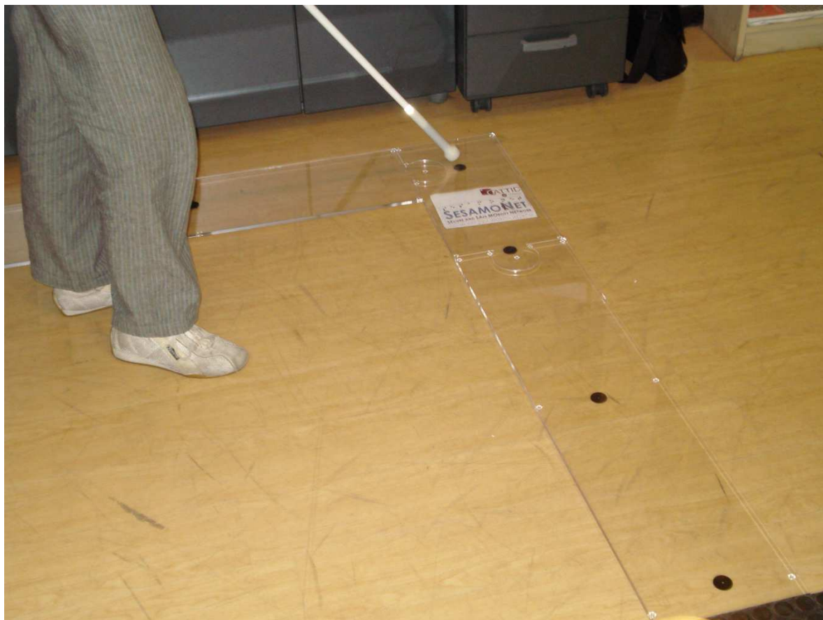
Figura 19. Installazione con pedane in metacrilato
