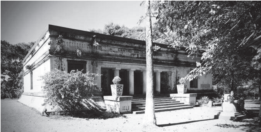
Fig. 4. Escuela Delfina por el Arq. Augusto Baratta, Moncagua, San Miguel. Fuente: Guía de Arquitectura de El Salvador (inédito). Junta de Andalucía/DOE.
