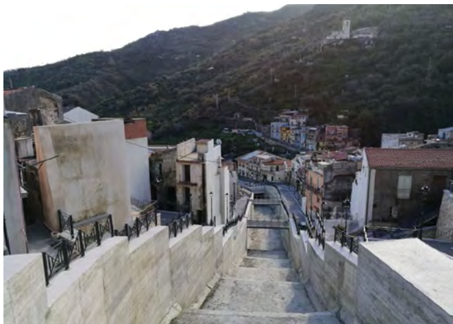
Fig. 13.3 – Giampileri: il canale con la rimodellazione dell'alveo
