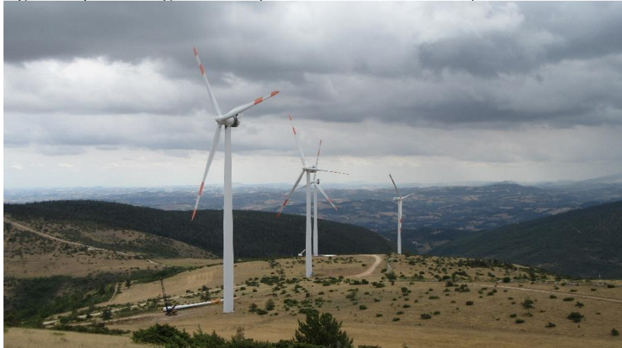
Fig. 1 – I quattro aerogeneratori del parco eolico Monte d’Aria, in provincia di Macerata
