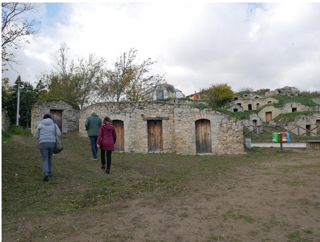
Fig. 23 – Sopralluogo del gruppo di lavoro del MiC, Parco Urbano dei Palmenti di Pietragalla, novembre 2024. Foto: Mona Mariacristina.
