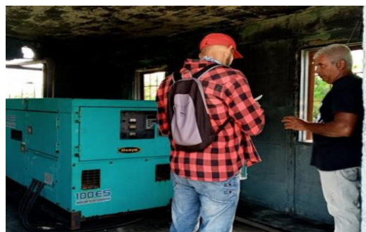
Fig. 8. Grupo electrógeno (GE) de Guasasa. Panel izquierdo: condiciones del GE. Panel derecho: técnico que tiende el GE. Fuente: FRE local.
