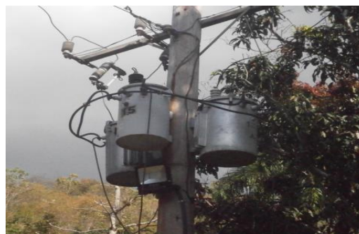
Fig. 11: Condiciones de la minihidroeléctrica.
