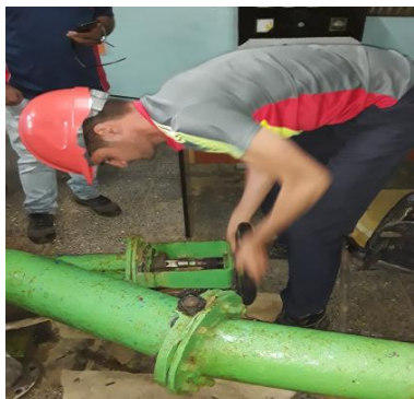
Fig. 12: Operador regulando el flujo de forma de agua manual. Fuente: Base de datos Proyecto FRE local
