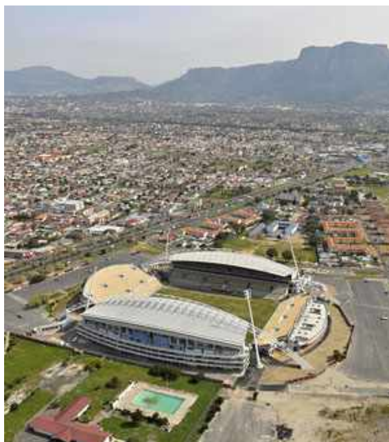
Figura 7.10: Athlone Stadium (immagine dal sito www.capetown.gov.za )
